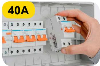
Ne branchez pas la machine sur des prises de faible puissance. Connectez la machine directement à un tableau électrique.
